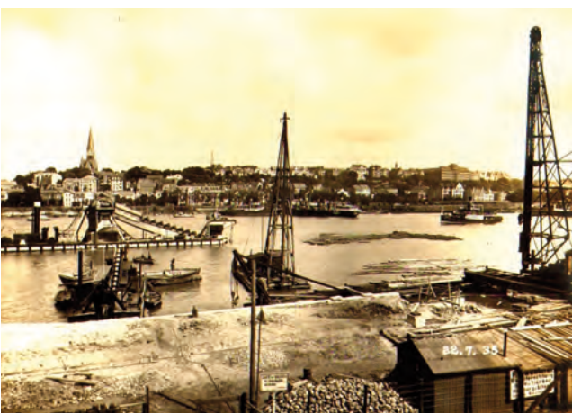
Die Aufschüttung hat eine Modderinsel hochgedrückt und der schwimmende Schaufelbagger muss sie entsorgen.
