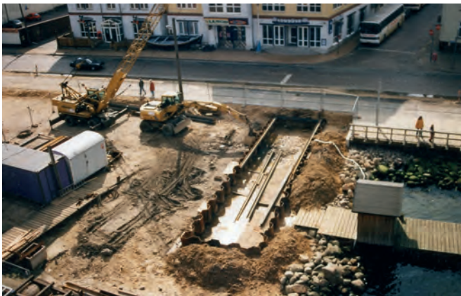
B au des Regenwasserrückhaltebeckens am Nordende des Bohlwerks, Höhe Norderfischerstraße.
