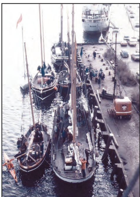
Wir beginnen die Rammarbeiten mit unserem zur Ramme umgebauten Bagger, die ersten Pfähle für den Laufsteg sind gesetzt
