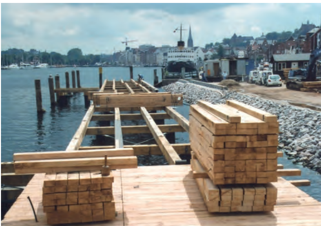
A nschüttung der Uferkante und Verlegung des neuen „Bohlwerk“ Laufsteiges freistehend im Wasser mit Zugangsplattformen am Nord- und Südende.
