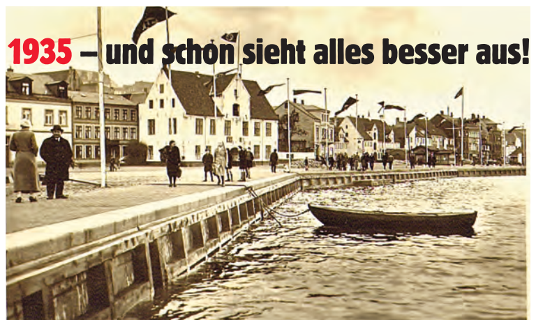
1935 ist schon alles fertig, Die Betonkante ist mit dicken Bohlen geschützt. Bauzeit: 1 Jahr!
