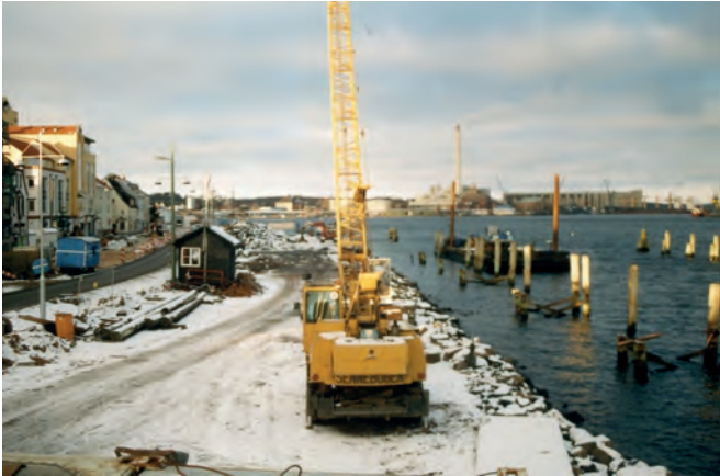
R ückbau des alten Bohlwerks
