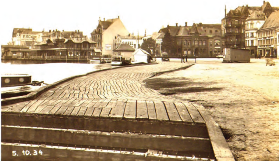
Blick nach Süden: Links der alte Dampferpavillon. Zwischen der dunklen Zeile und dem weißen Gebäude rechts (heute Rock-Café) ist der Zugang zum Nordermarkt. Alles sackt auf ganzer Linie weg, es ist Handlungsbedarf.
