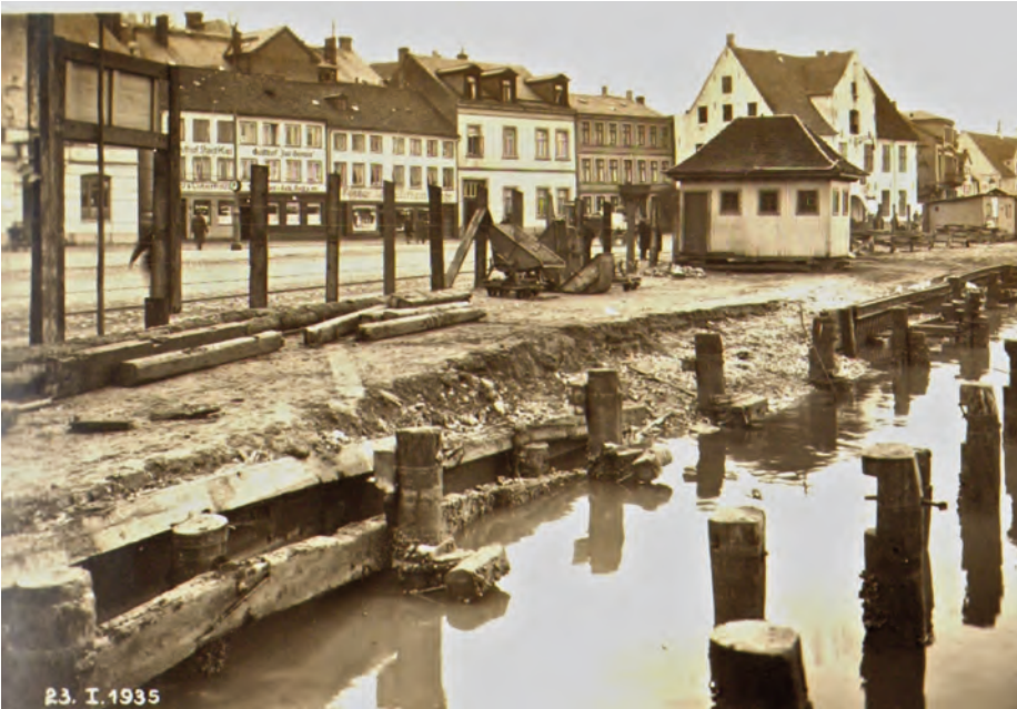
Der Bohlenbelag ist entfernt, die Pfähle müssen noch gezogen werden. Hinter der Hütte das damals weiße Kompagnietor.
