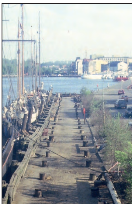
Alle Pfähle für den Laufsteg sind gerammt.
